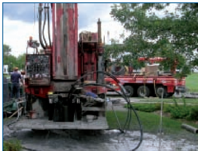
Il existe aussi des foreuses rotatives qui peuvent forer à des grandes profondeurs jusqu'à six pouces de diamètre pour y insérer un chemisage d'acier dans lequel sera glissé les tuyaux de plastique qui formeront des boucles souterraines verticales.
